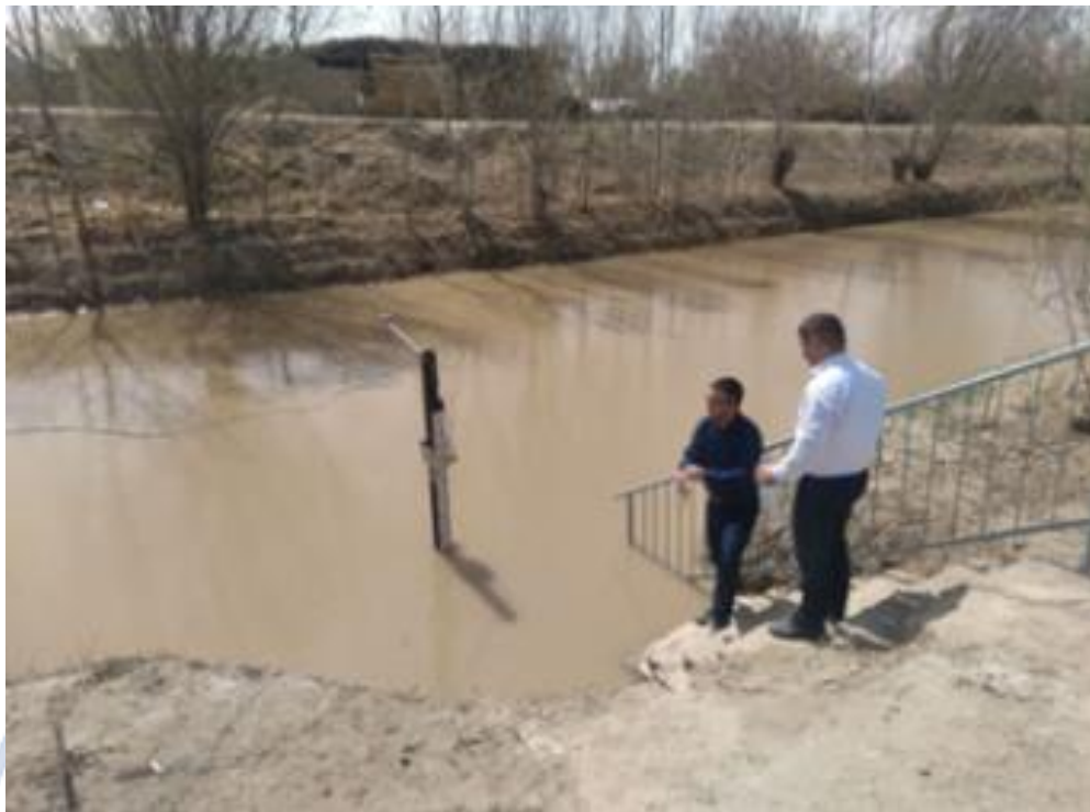
2-rasm. Qulobod kanalidagi Smart Water qurilmasi.
